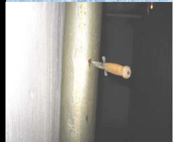
Bildet viser avløpstamme i kjeller som har tydelige forekomster av rust. Kniv gikk gjennom rørvæggen ved kontrollen.
